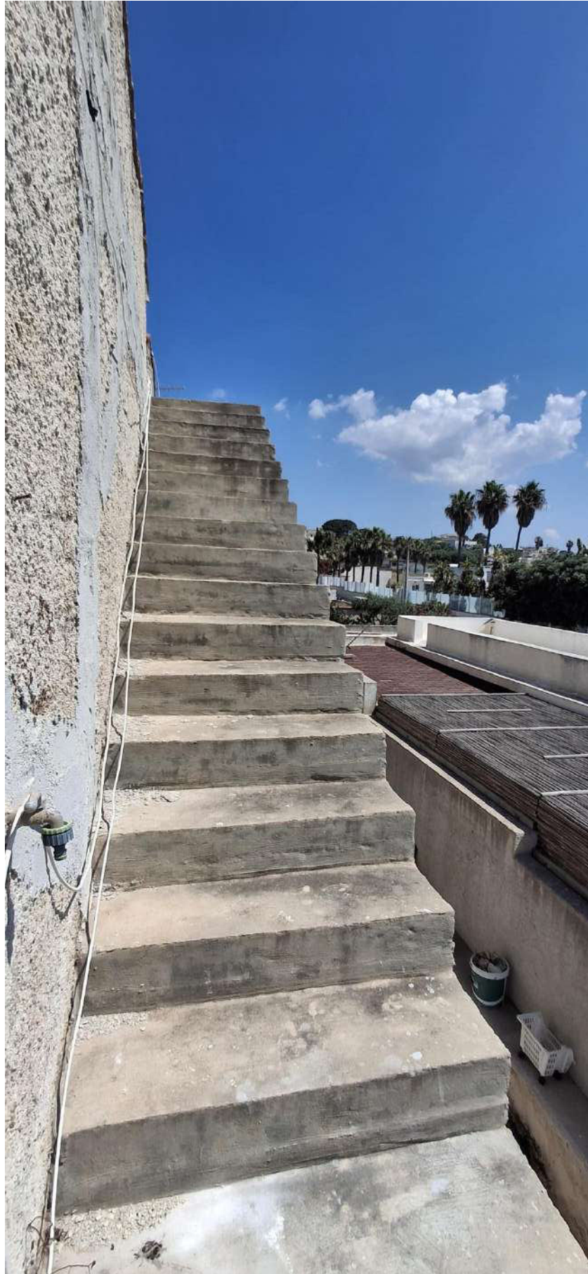
Foto 12: scala per accesso a lastrico solare
