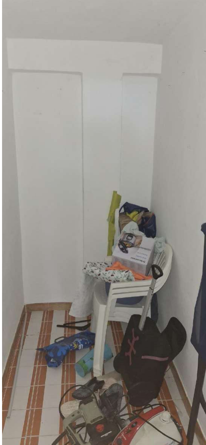
Foto 25: ripostiglio piano terra
