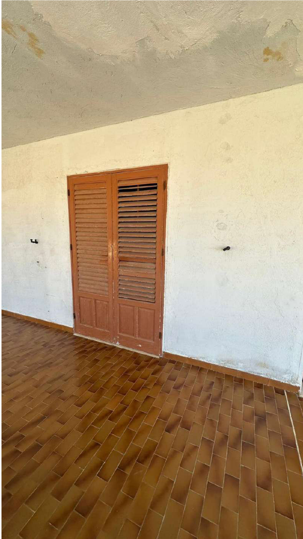
Foto 1: infisso esterno piano 1
