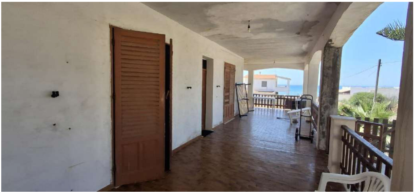
Foto 20: vista mare da veranda piano 1
