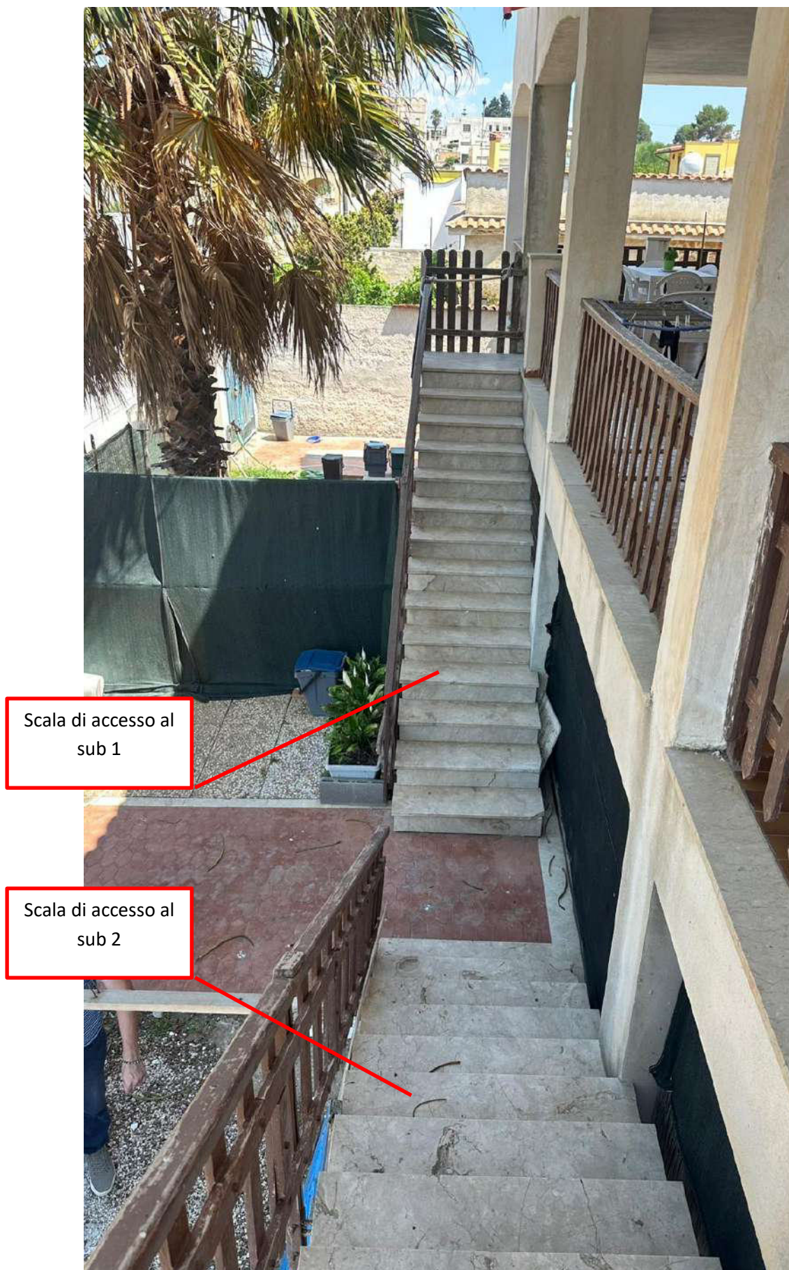
Foto 3: scala di accesso al piano 1
