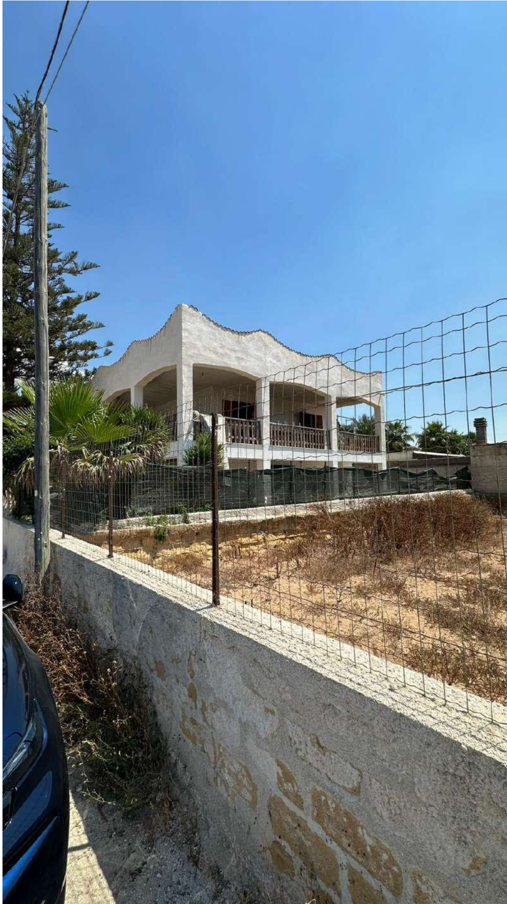
Foto 4: vista lato sud
